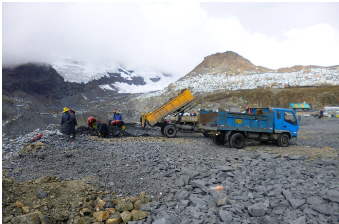
Fotografía N° 1.8 Equipos Canter descargando desmonte en el botadero - Rinconada
