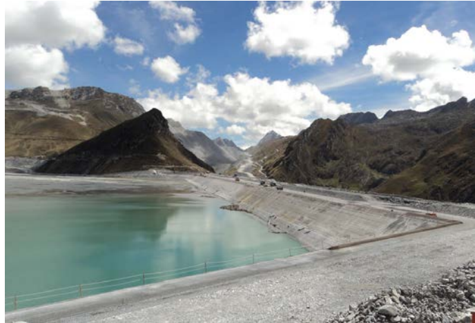
Figura 9. Presa de relaves.
